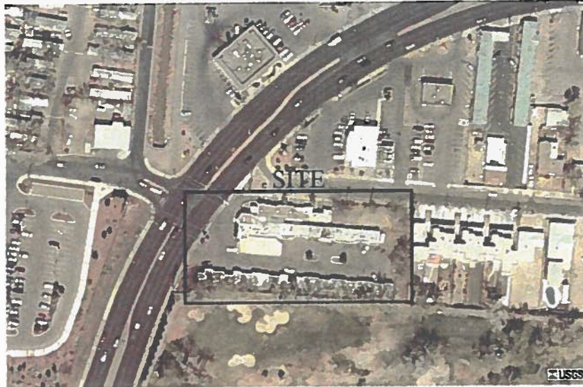
EL VADO MOTEL 2500 CENTRAL AVE SW
